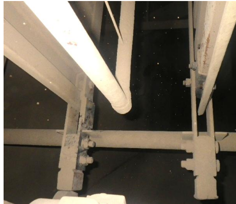
집진극 보강 LINER 설치
