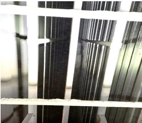
집진극 고정 CLAMP 설치
